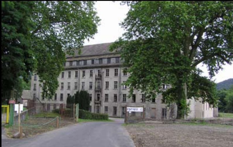
un bâtiment destiné à accueillir de l'habitat
